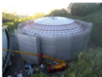
▲配水池築造工事
