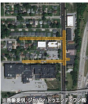
▲衛星画像データによる漏水エリアの特定
