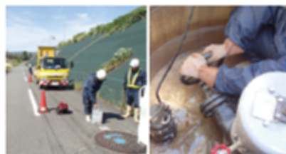
▲管路の点検業務
