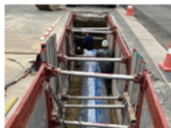
▲送水管更新工事
