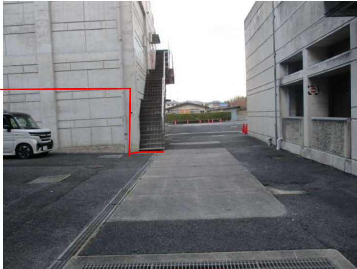
B 電線管、壁面へ添架
