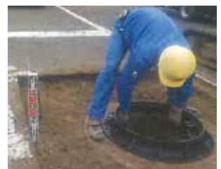
▲マンホール蓋取替工事
