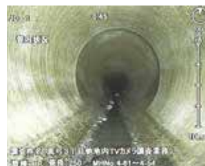
▲TVカメラによる管内調査
